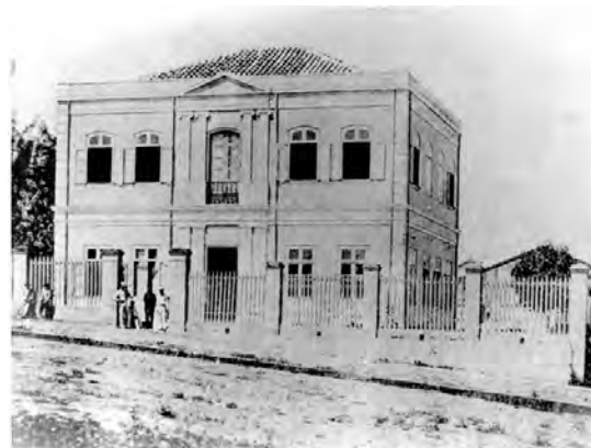
Figura 1. Casa de Câmara e Cadeia, em foto de 1910: edificação em tijolos aparentes, a partir da planta do engenheiro militar Euclides da Cunha, erguida em 1887. Acervo do Autor
