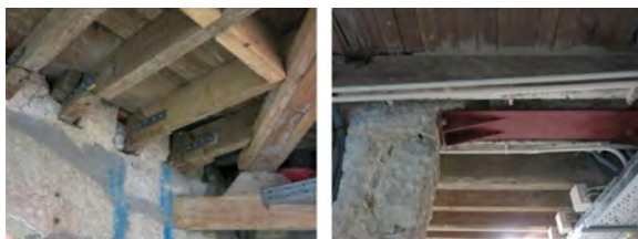
Figura 34 – Obras da 2ª Fase
