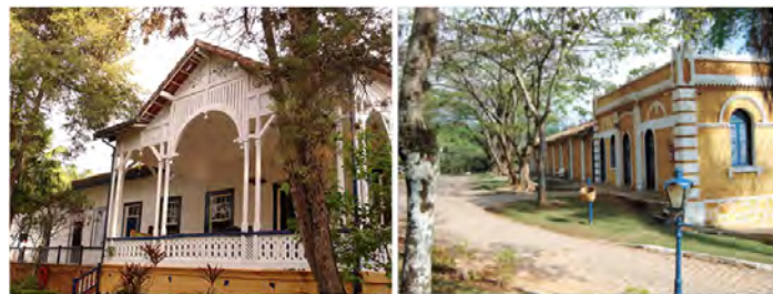
Figuras 1 e 2. Fachada da Casa Grande na Fazenda Duas Pontes em Campinas e edificação do complexo que pertenceu a Joaquim Ferreira Penteado, o Barão de Itatiba. (Fonte: http://www.jornaldaserra.com.br/15%20Hotalaria/Solar%20das%20Andorinhas/1solargeral.html acessado dia 17/02/2016 as 19:11)
