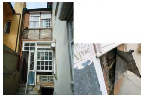
Figura 7 – Início da Obra
