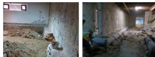
Figura 33 – Obras da 2ª Fase
