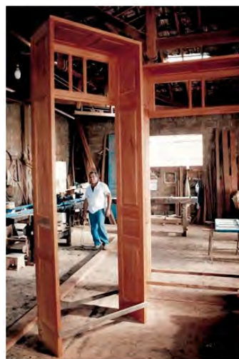
Figura 6. Os montantes de portas e janelas tiveram que ser substituídos e adaptados: madeira de melhor qualidade e resistência, somada ao saber técnico de tradicional família de marceneiros da cidade. Foto do Autor, 1999.
