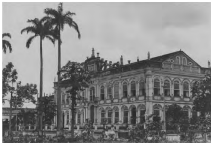
Figura 12 – Vista das fachadas principal (nordeste) e lateral (noroeste) do corpo principal do Solar Machado. Fonte: Fundação Instituto Feminino da Bahia (FG-4108)
