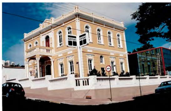
Figura 4. SENAC São João da Boa Vista, pronto para inauguração após reforma, restauração e construção de anexo. Foto do Autor, 2000
