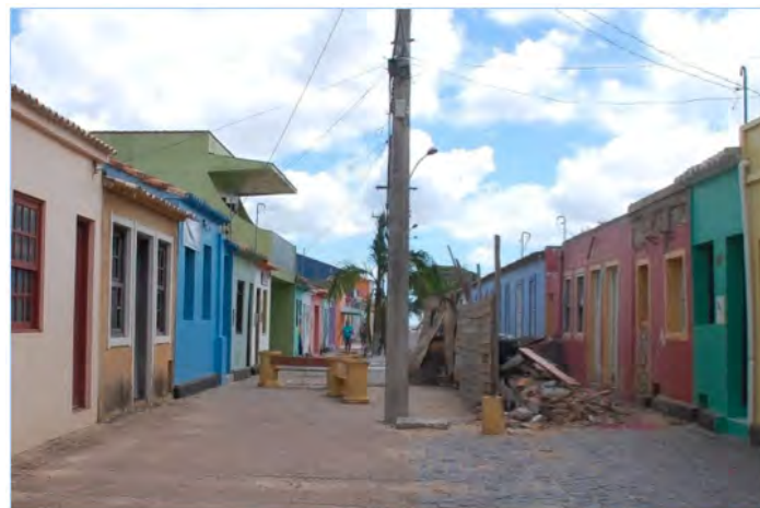
Figura 1: Anexo da Câmara Municipal irrompe no espaço público. Fonte: Autora, 2014.
