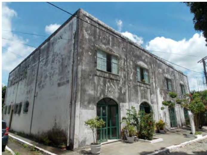
Figura 11 – Vista geral das fachadas lateral esquerda (sudoeste) e principal (sudeste) do Pavilhão de Terapia Ocupacional. Fonte: Acervo A&P Arquitetura e Urbanismo.
