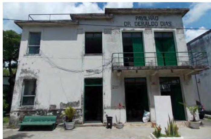
Figura 10 – Vista geral da fachada principal (sudeste) do Pavilhão Dr. Deraldo Dias. Fonte: Acervo A&P Arquitetura e Urbanismo.
