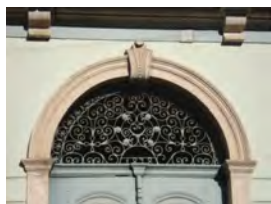
Figuras 10, 11 e 12. Figura 10. Nas portas externas do piso inferior foram utilizadas bandeiras de ferro em arco pleno e guarnições de pedra de cantaria e duas folhas de madeira almofadada. Figura 11. Bandeira de ferro com a data da construção: 1878. Figura 12. Nas portas balcão do piso superior foram utilizadas guarnições em madeira.
