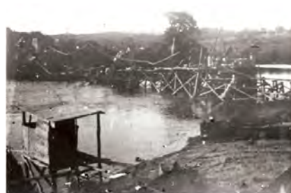
Figura 2: Início dos trabalhos de reconstrução da ponte metálica.
