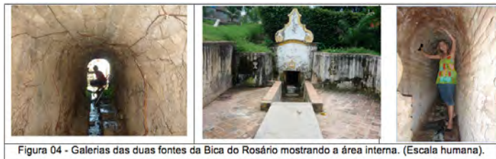
Figura 04 - Galerias das duas fontes da Bica do Rosário mostrando a área interna. (Escala humana).
