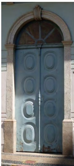
Figuras 10, 11 e 12. Figura 10. Nas portas externas do piso inferior foram utilizadas bandeiras de ferro em arco pleno e guarnições de pedra de cantaria e duas folhas de madeira almofadada. Figura 11. Bandeira de ferro com a data da construção: 1878. Figura 12. Nas portas balcão do piso superior foram utilizadas guarnições em madeira.
