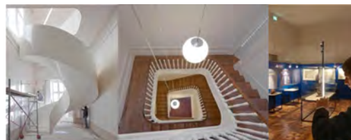
Figura 31 – Obras da 1ª Fase
