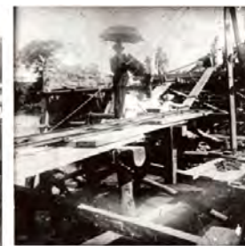
Figura 3: Sob a supervisão de Euclides, a ponte metálica começou a ser desmontada em 1898.
