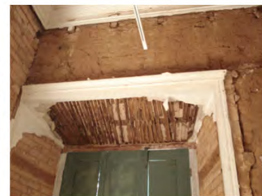
Figuras 8 e 9. Figura 8. Pintura no interior do Palácio dos Azulejos. Figura 9. Técnicas construtivas: foram usadas duas técnicas construtivas na construção do Palácio dos Azulejos: Taipa de Pilão e Alvenaria de Tijolos.
