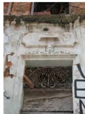
Figura 3- Foto da autora. 07/2008. Edif. 47-53. Detalhe da Fachada da Rua do Taboão. Direita.
