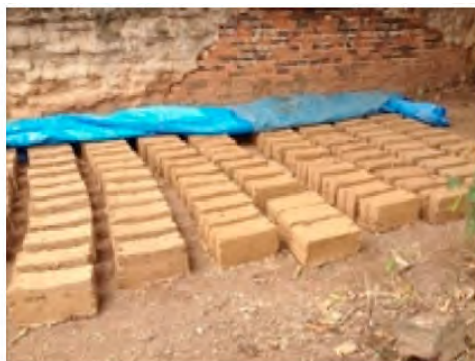
Figura 06 – Adobe produzido no canteiro de obras. Fonte: Iphan-MT, 2015.
