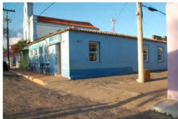
Figura 3: A edificação atual, após várias modificações. Fonte: Autora, 2014.
