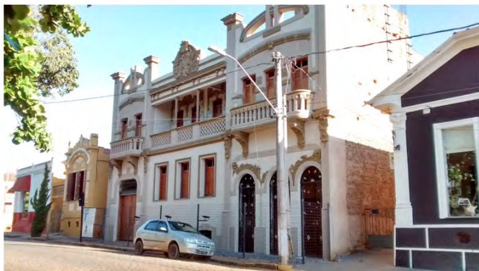
F Figura 3: Fachada restaurada, com obra parcialmente concluída. 19/03/2016. FONTE: arquivo pessoal do autor.
