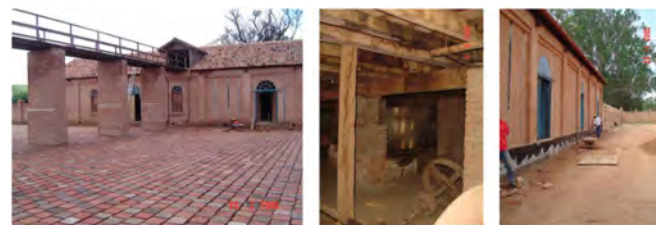
Figura 6 - Edifícios da Unidade Industrial da Fazenda de São Vicente – terreiro, tulha, casa das máquinas (créditos: Maria Rita Amoroso)
