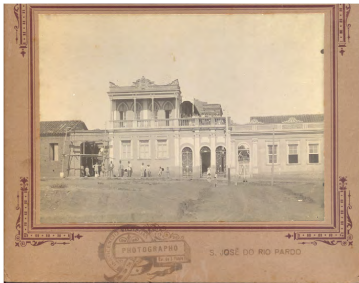
Figura 1: Vista do sobrado em reforma, sem data. FONTE: Arquivo iconográfico do Centro de Memória Rio-pardense.
