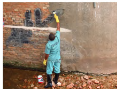
Fig. 14 e 15 - Consolidação da Ponte Torta pela equipe do Estúdio Sarasá.
