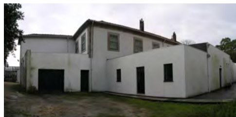
Figura 14 – Vista Geral da Casa Salabert
