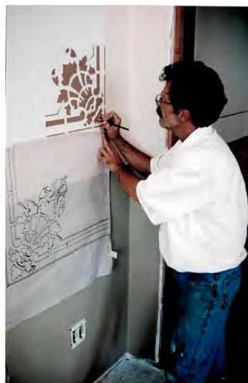
Figura 5. A prospecção no reboque revelou decoração refinada de 1905, dando oportunidade para recuperação da técnica de pintura decorativa na cidade. Na foto, correção dos moldes originais, desgastados pelo uso. Foto do Autor, 2000
