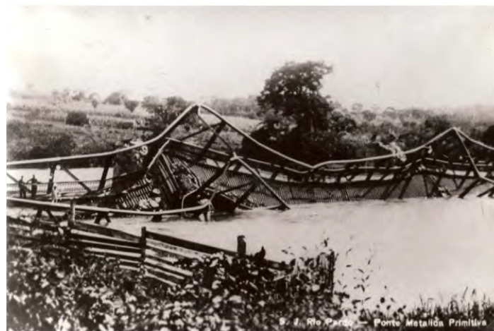
Figura 1: Após escavação em um dos pilares, a ponte metálica desabou no rio Pardo.
