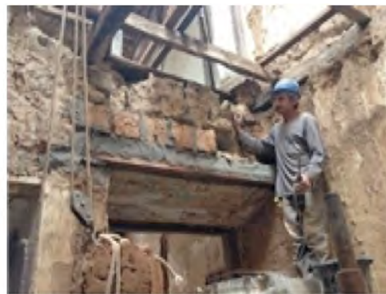
Figura 07 – Utilização de adobe na vedação. Fonte: Iphan-MT, 2015.
