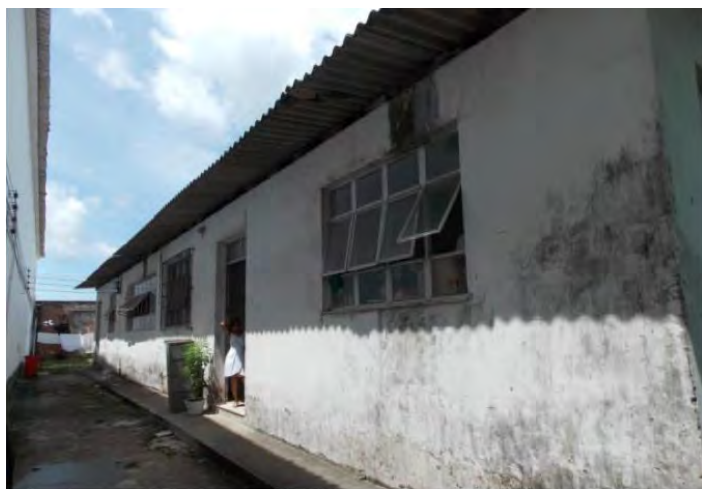
Figura 09 – Vista geral da fachada principal (sudeste) do Pavilhão da Lavanderia. Fonte: Acervo A&P Arquitetura e Urbanismo.
