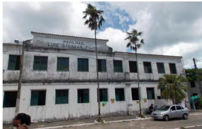
Figura 08 – Vista geral da fachada principal (sudeste) do Pavilhão Luiz Salazar Filho. Fonte: Acervo A&P Arquitetura e Urbanismo.
