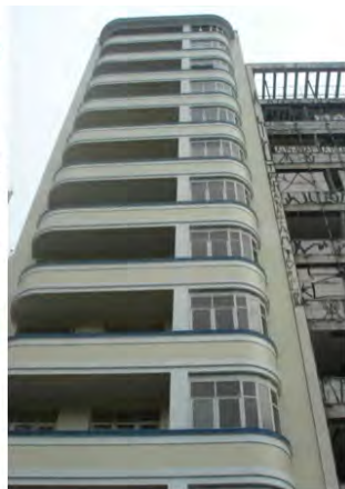
Fig. 23: Fachada do edifício Asdrubal do Nascimento com sua adaptação para habitação. Fonte: Autografics.
