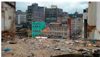
Figura 14- Edifício 43-57. Vista para a área do Comercio, o no nível da Rua do Taboão (de cima).
